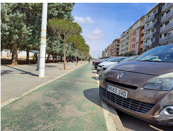
Ocupación del carril bici. Catarroja, junto complejo deportivo en Av. Rei Jaume I (imagen tomada durante la inspección)
