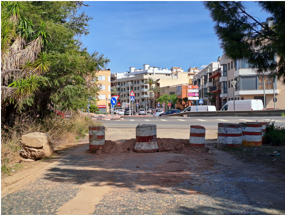
Bloqueo del paso ciclopeatonal (imagen tomada durante la inspección)
