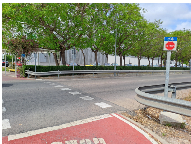
Señal de parada para el tráfico ciclista en intersección de vía interurbana (fotografía tomada durante la inspección)
