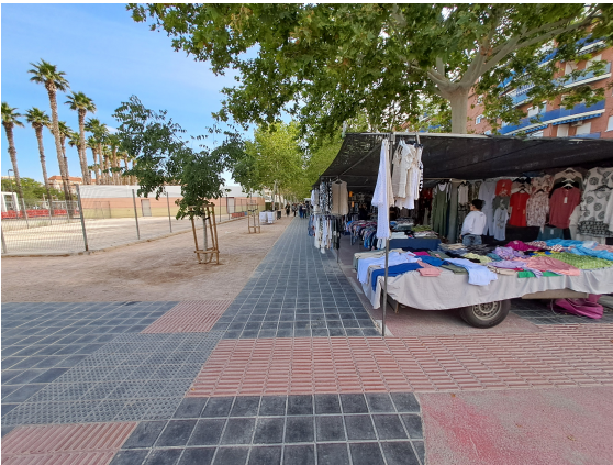
Ocupación del carril bici por emplazamiento de mercado ambulante en Alaquàs (imagen tomada durante la inspección)
