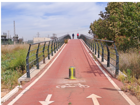
Bolardo situado obstaculizando la circulación del carril (imagen tomada durante la inspección)
